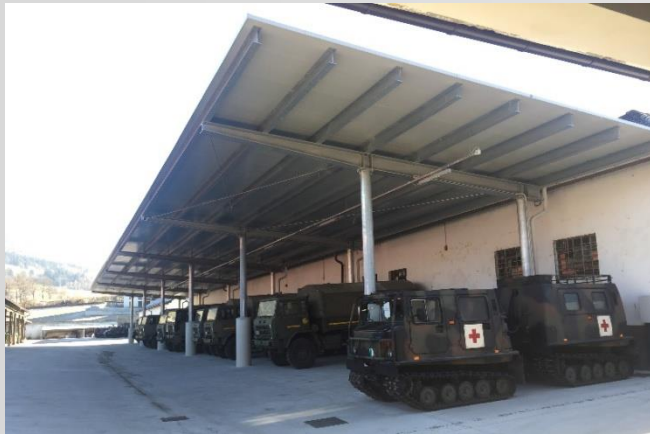
Nuova tettoia ricovero automezzi
