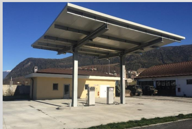
Nuovo deposito carburanti
